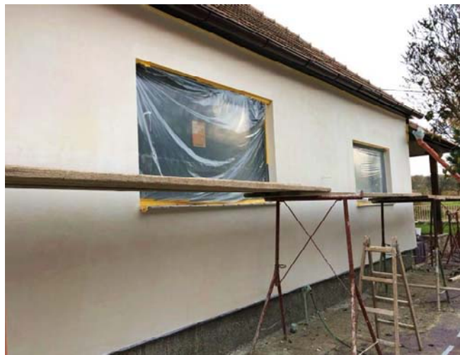
Vernetzung der Fassade inkl. Mansardenbereich.
